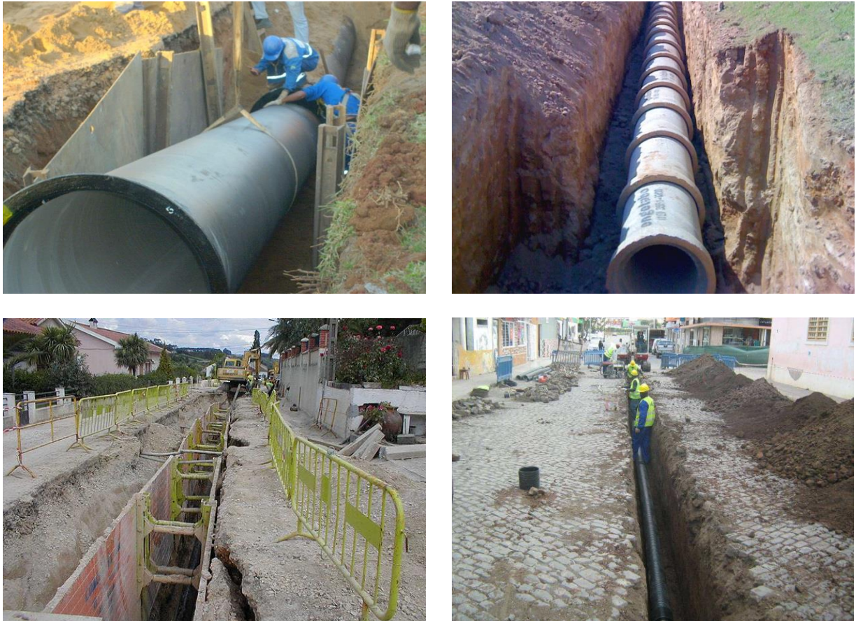
Figura 9 - Implantação de rede de coletores (Fonte: anteprojetos.com.pt)
