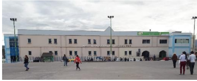
Figura 36: Mercado Cerrado “Latacunga” Fuente: Elaboración Propia (2018)
