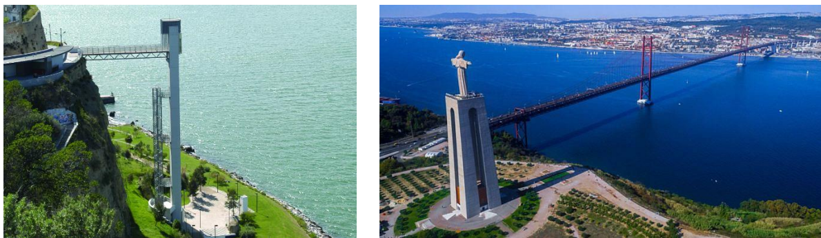
Figura 71: Elevador da Boca do Vento & Cristo Rei
