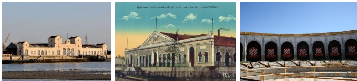
Figura 70: Estação Fluvial - Oficinas Caminhos de Ferro do Sul e Sueste
