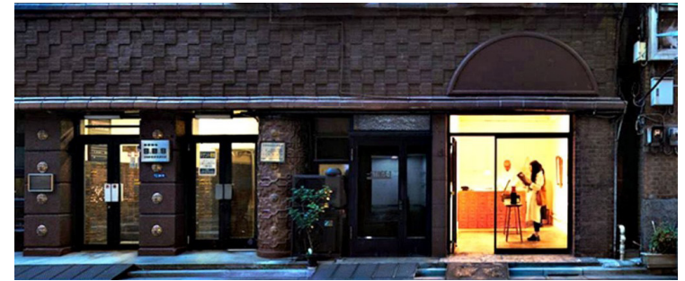
Imagem 26 Fachada do edifício da livraria Marioka Shoten, Tóquio, Japão
