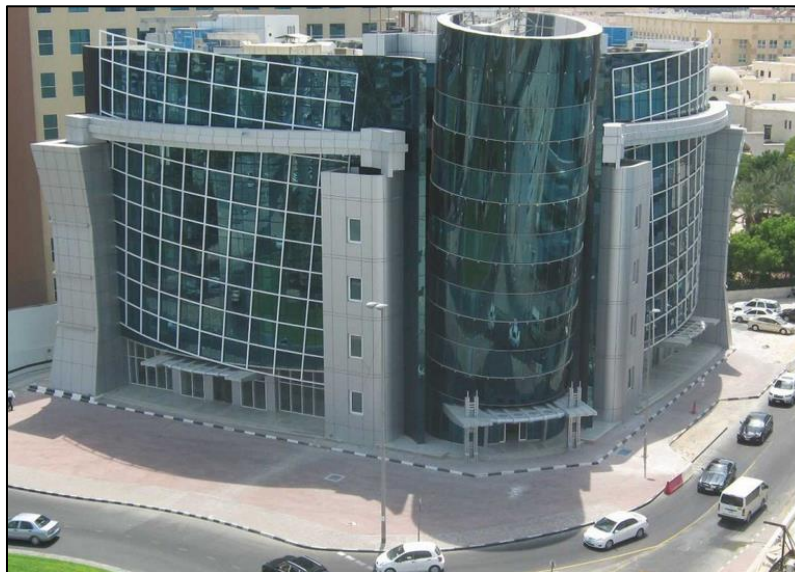
Figura 3. Al Gurg Office Tower, Emirados Árabes Unidos, edifício contruído com fachada curtain wall em alumínio. Fonte: (Reynaers Aluminium 2015)
