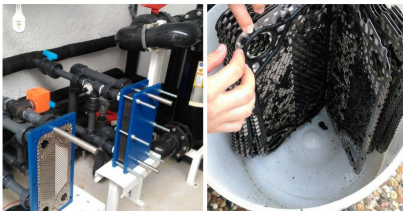
Figura 9- Limpeza dos permutadores (Fonte: Própria).
