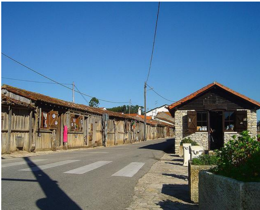
Figura 1.8 Rua principal com as casas típicas das salinas de Rio Maior
