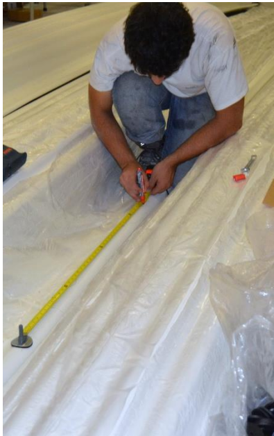
Figura 50 – Marcação da furação
