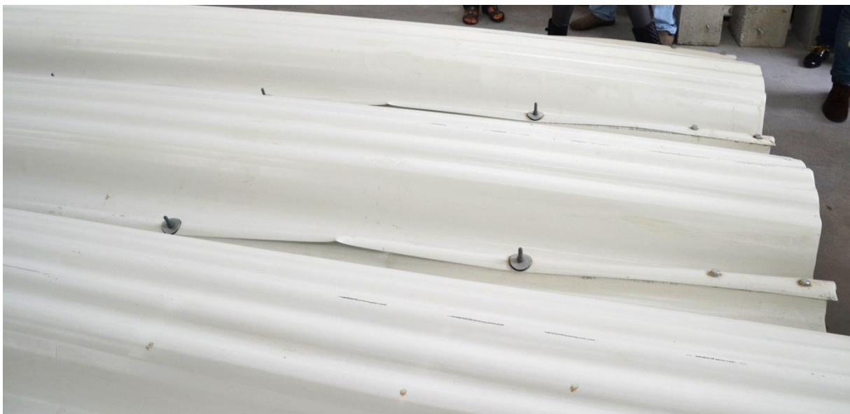
Figura 74 – Deformações da sobreposição perto dos apoios
