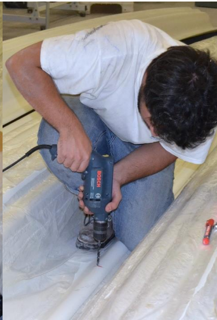
Figura 51 – Execução da furação
