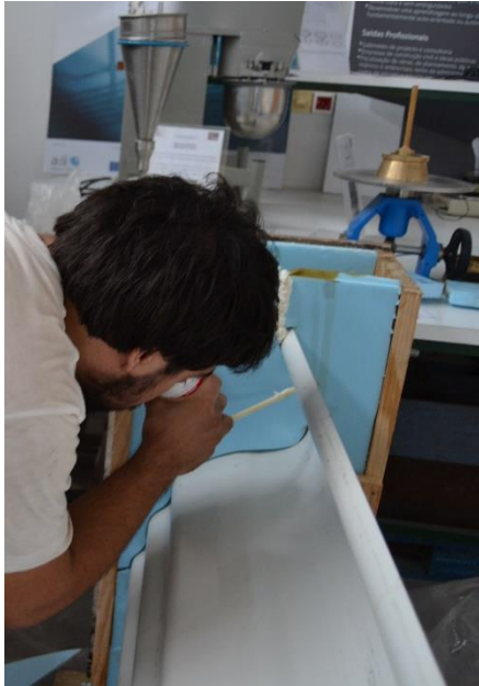
Figura 34 – Aplicação de espuma de poliuretano nas aberturas
