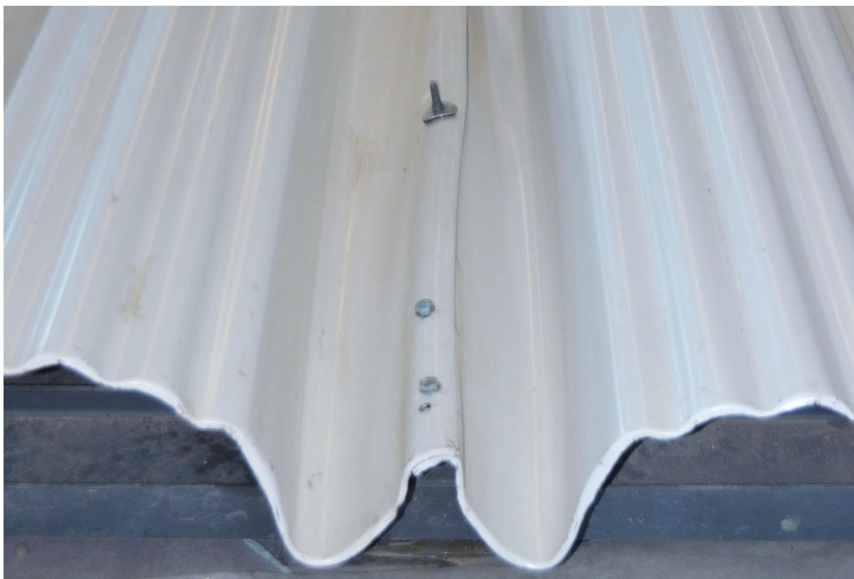
Figura 79 – Rotação da sobreposição junto dos apoios
