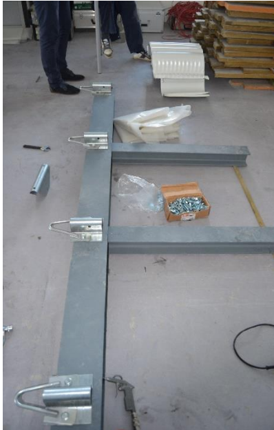
Figura 46 – Montagem da metade inferior dos apoios
