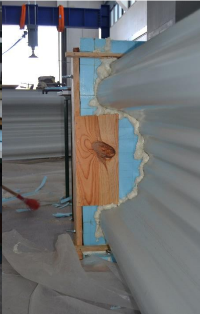
Figura 35 – Cofragem finalizada
