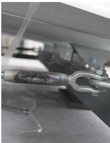
Figura 56 – Soldadura dos tirantes
