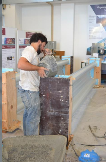
Figura 36 – Betonagem dos topos
