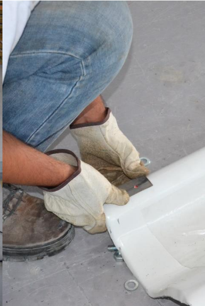
Figura 47 – Marcação da furação dos cavaletes
