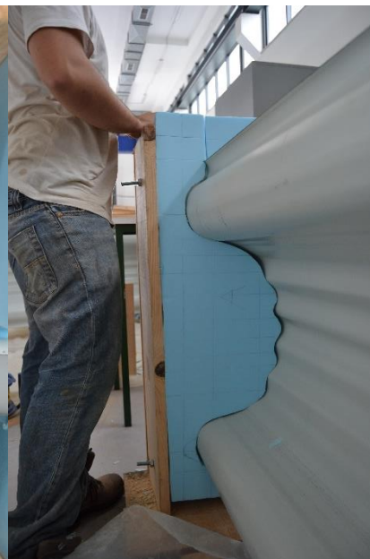
Figura 33 – Placa de cofragem personalizada frontal
