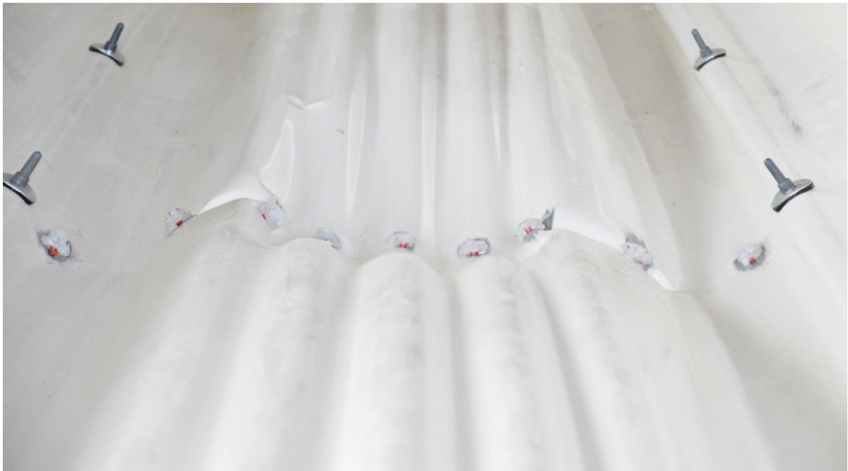
Figura 78 – Rotura da secção a meio vão
