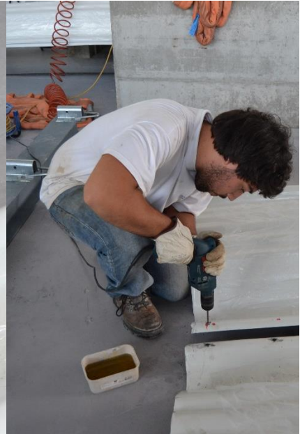
Figura 48 – Furação para os cavaletes
