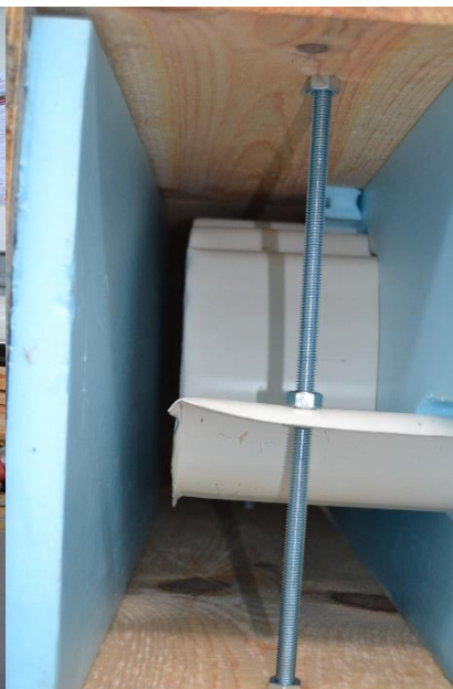
Figura 32 – Varões roscados para alinhamento da telha
