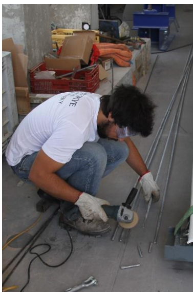
Figura 55 – Corte dos tirantes
