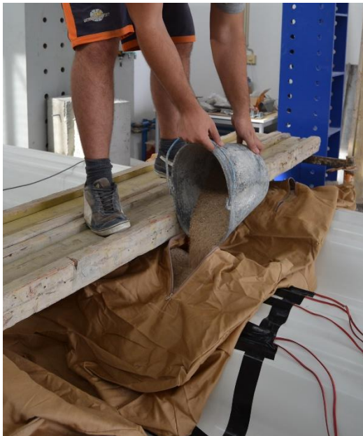
Figura 70 – Enchimento dos sacos de areia
