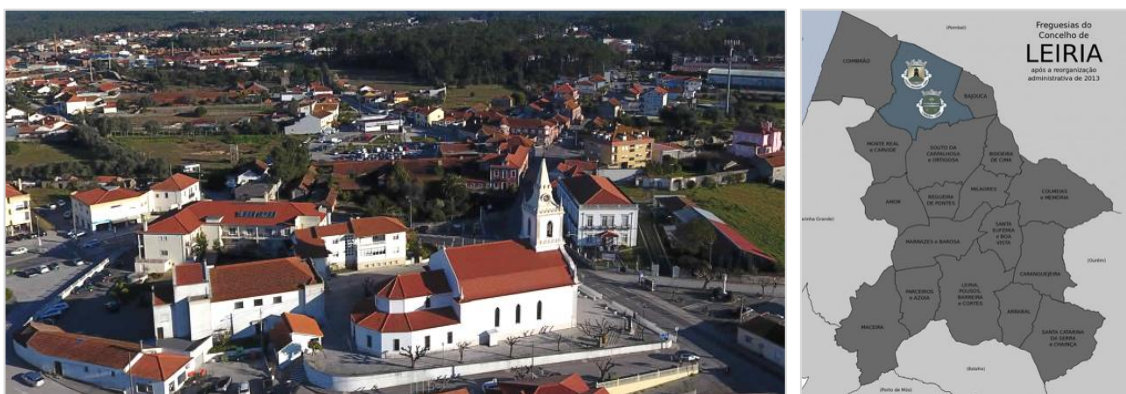
Figura 2 - Vista aérea da localidade de Monte Redondo e mapa do concelho de Leiria
