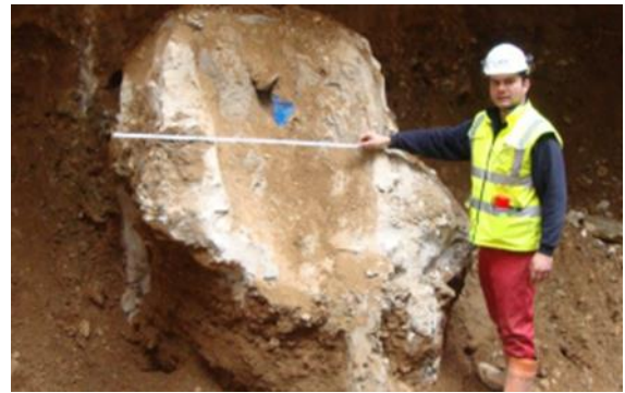
Figura 4.9 - Medição do diâmetro da coluna de teste de jet grouting [35]
