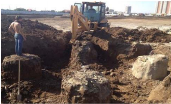
Figura 4.8 - Exposição das colunas de teste de jet grouting [46]
