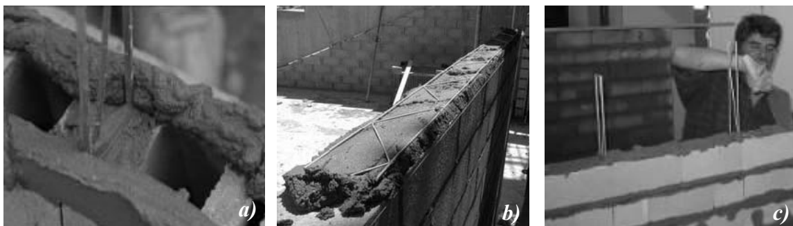
Figura 7 - Construção em alvenaria armada; a)Execução de alvenaria de blocos de cimento com armadura horizontal tipo Murfor [28]; b),c)Execução de alvenaria estrutural em blocos de betão com armadura vertical do tipo Murfor [44].
