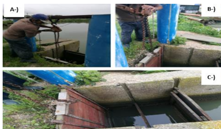
Figura 43 - A-) e B-) – Abertura da comporta; C-) fecho de comportas dos viveiros (tanques) (imagens do próprio)
