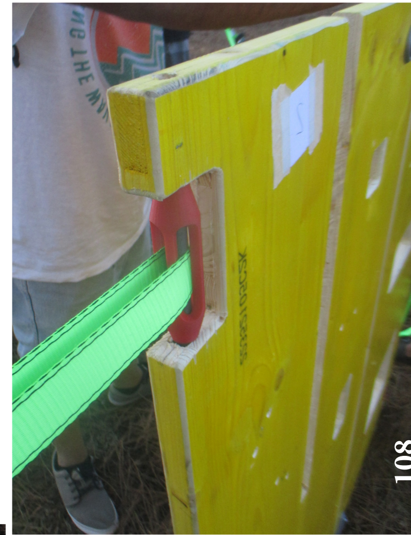
Fig. 106 - Aperto de encaixes aos painéis. Fig. 107 - Painéis agregados. Fig. 108 - Passagem da fita de suspensão entre eixo e proteção. Fig. 109 - Esticador de fita.
