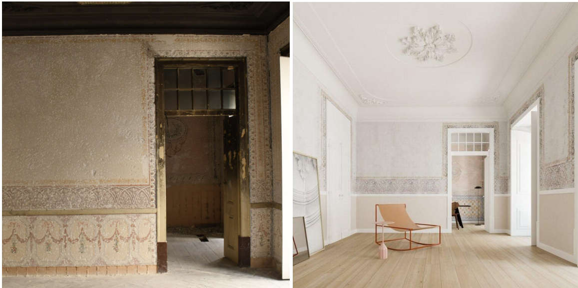
Figura 4.3: Antes da obra e depois do projeto
