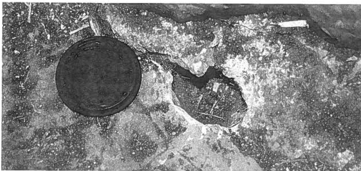
Fig. 46. Orifício causado pelo crescimento de uma planta da espécie Piptatherum miliaceum .
