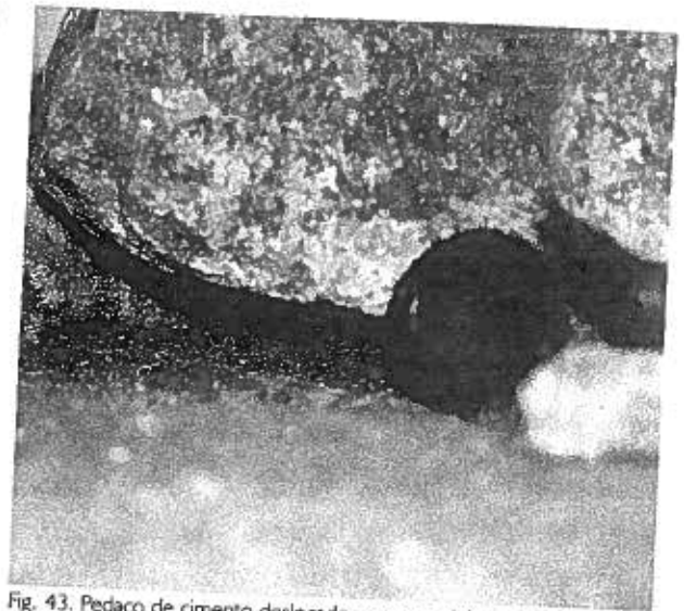
Fig. 43. Pedço de cimento deslocado e espaço deixado livre pela remoção das raízes - levantamento 16T.
