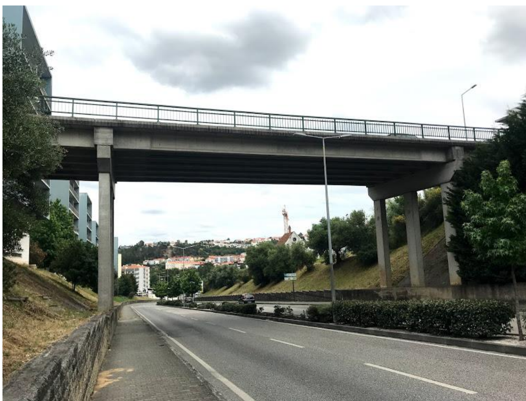
Figura 18 - Vista geral do viaduto.
