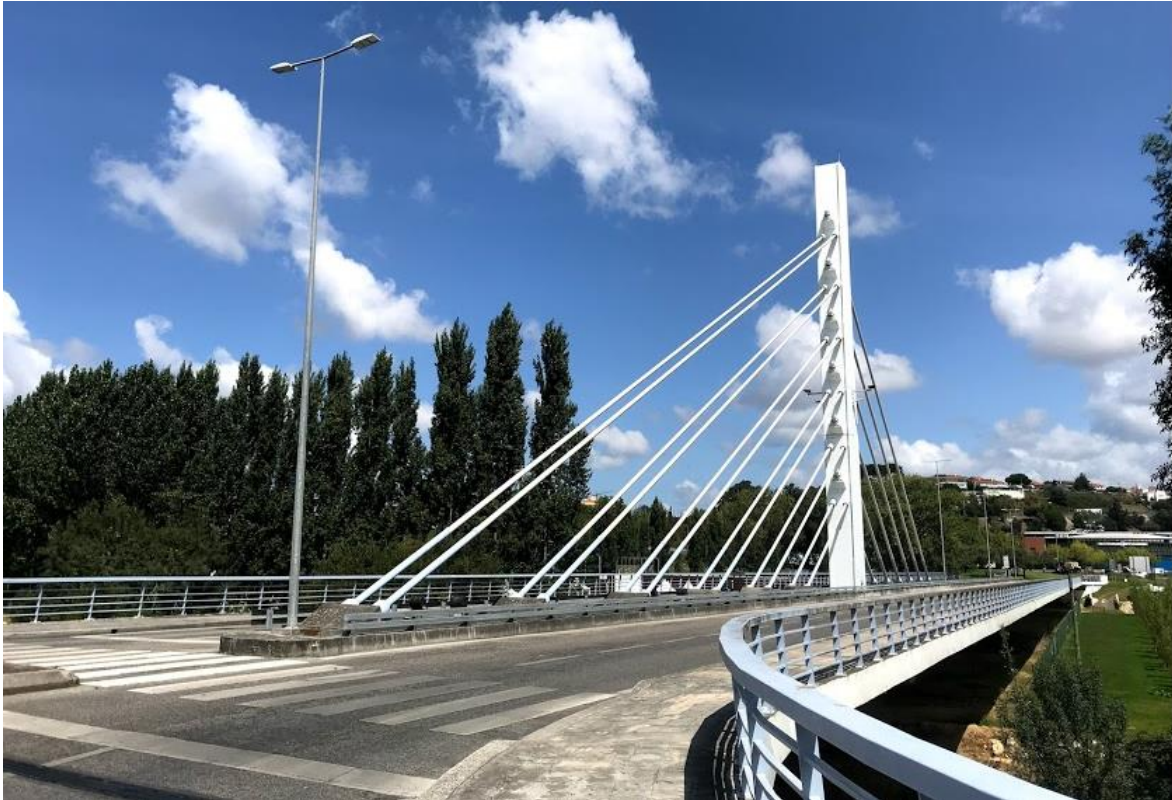
Figura 50 - Vista geral da Ponte Euro 2004.
