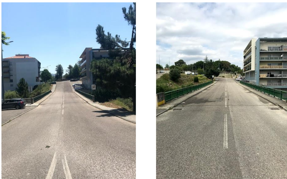
Figura 23 - Acessos ao viaduto.
