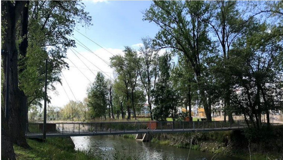
Figura 43 - Vista geral da Ponte Pedonal.
