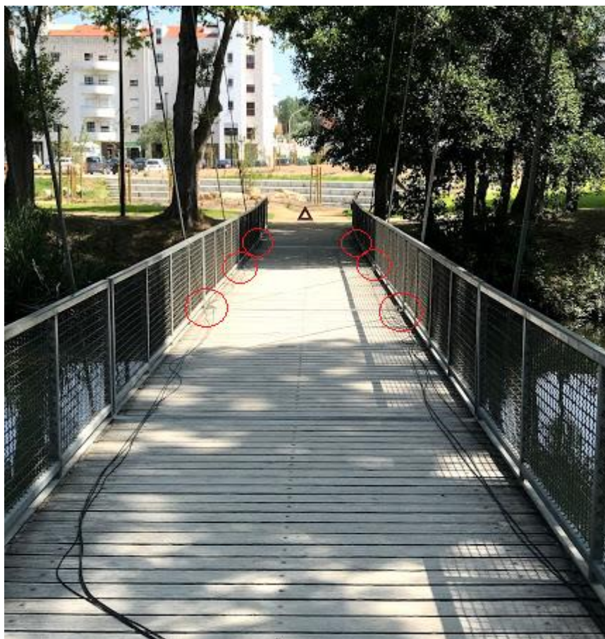
Figura 78 - Posicionamento dos acelerómetros para segunda tipologia de ensaios na Ponte Pedonal Metálica.
