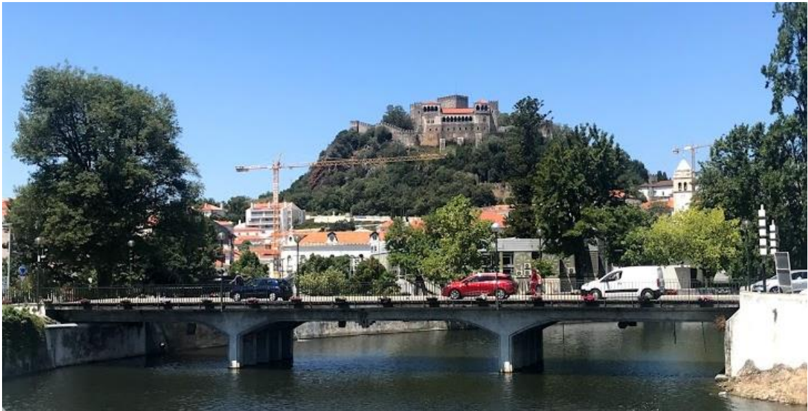
Figura 30 - Vista geral Ponte Afonso Zuquete.
