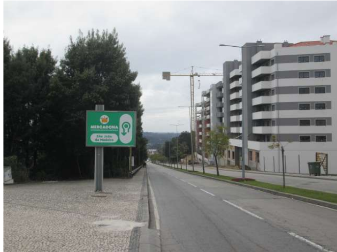
Figura 21 – Passeio (à esquerda na foto) junto ao acesso à moradia
