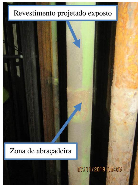
Figura 4.17 – Exemplo de desgaste observado após 32 meses de operação
