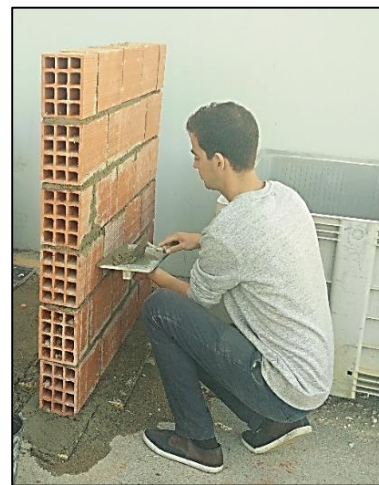
Figura 29 - Preenchimento das juntas verticais
