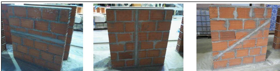
Figura 13 - Provetes com roços a ensaiar (Soares, F., 2012)
