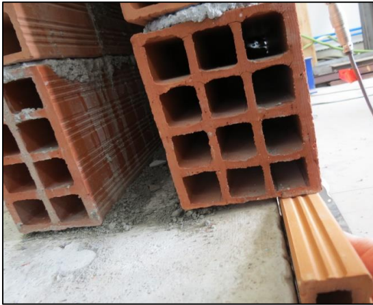
Figura 45 – Utilização da forra cerâmica para demonstrar o apoio parcial na base da parede de alvenaria
