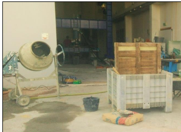
Figura 25 - Preparação da argamassa de assentamento
