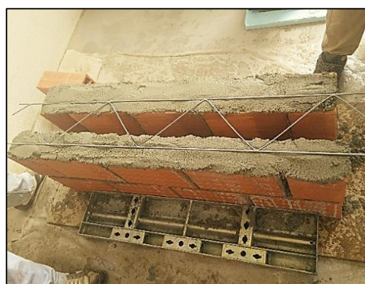
Figura 31 - Aplicação das armaduras
