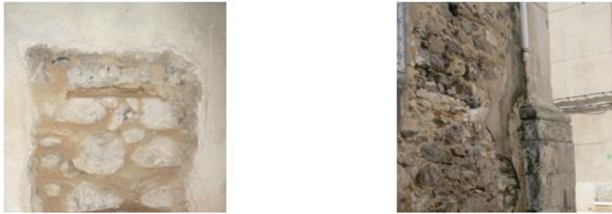
Figura 13 - Alvenaria de pedra calcária nos edifícios do CHL
