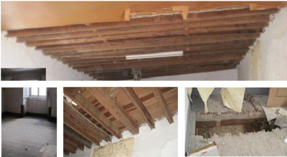
Figura 91 - Pavimentos de edifícios do CHL
