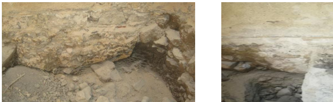
Figura 74 - Poços de inspeção das fundações de um edifício tradicional do CHL
