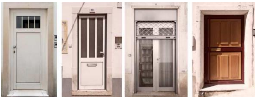
Figura 124 - a) Caixilharias em alumínio, afastamento da janela em relação à face exterior da parede, janela de correr [41]; b) Portas em alumínio lacado, anodizado à cor natural, com gradeamento exterior e porta em PVC [41]
