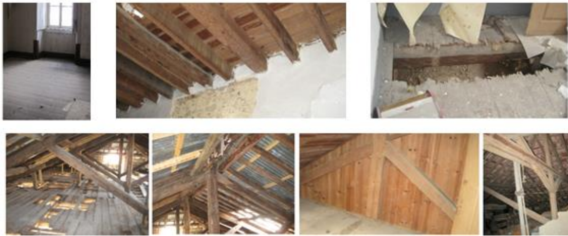
Figura 12 - Aplicação da madeira de pinho nos edifícios do CHL
