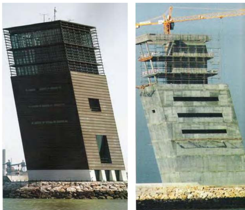
Figura 11 – Edifício do “Centro de Coordenação e Controlo de Tráfego Marítimo e Segurança” do porto de Lisboa [19].
