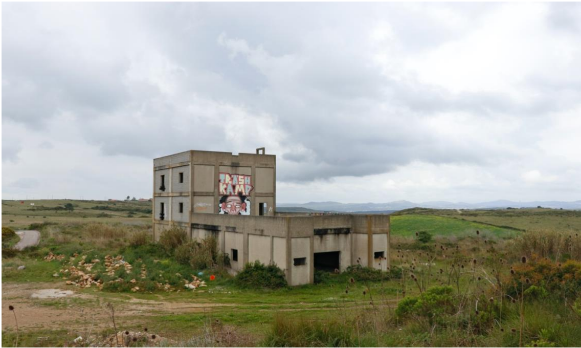
Anexos 27 - Fotografia Edifício Abandonado Fonte: João Mata
