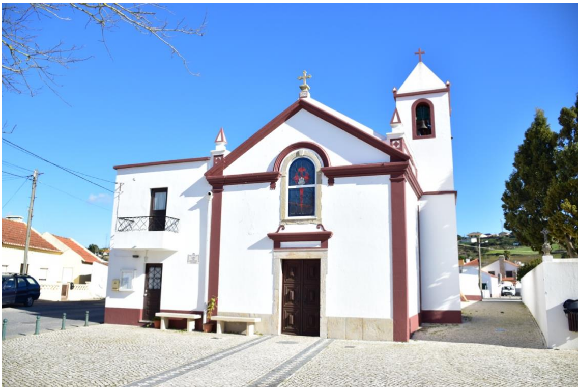
Anexos 21 - Igreja de S. Tiago dos Velhos Fonte: Município de Arruda dos Vinhos
