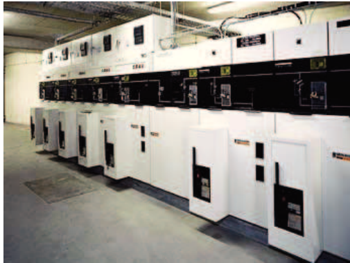
Figura 11 - Celas Modelares contendo SF 6
