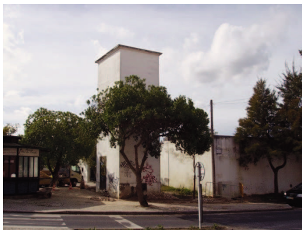
Figura 15 - Zona com PT Cabine
