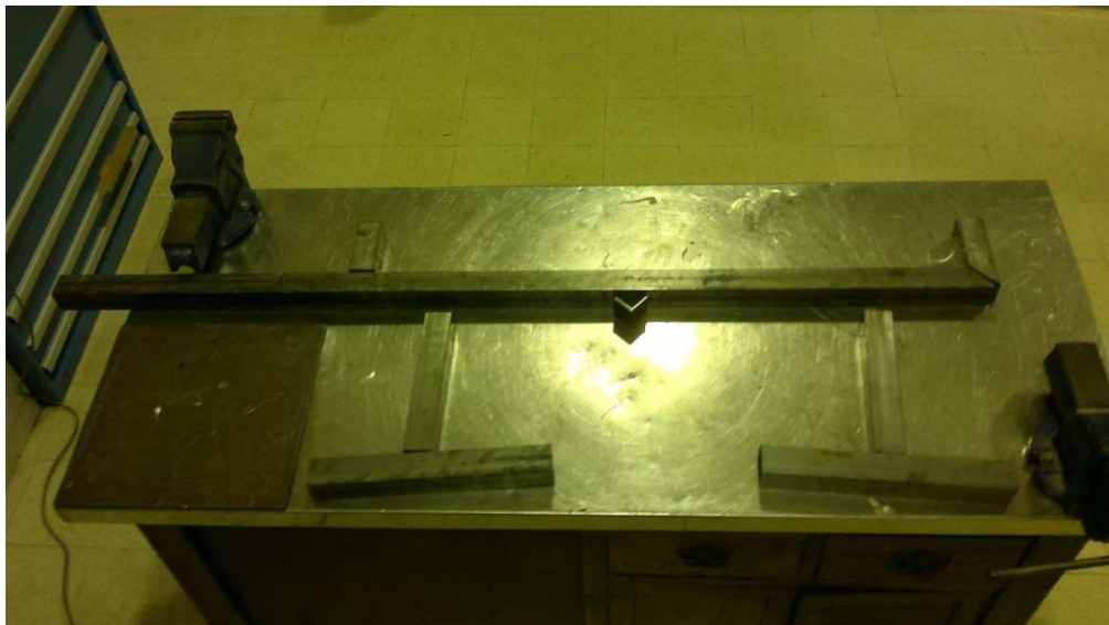
Figura 68 – Estrutura antes de ser soldada.
