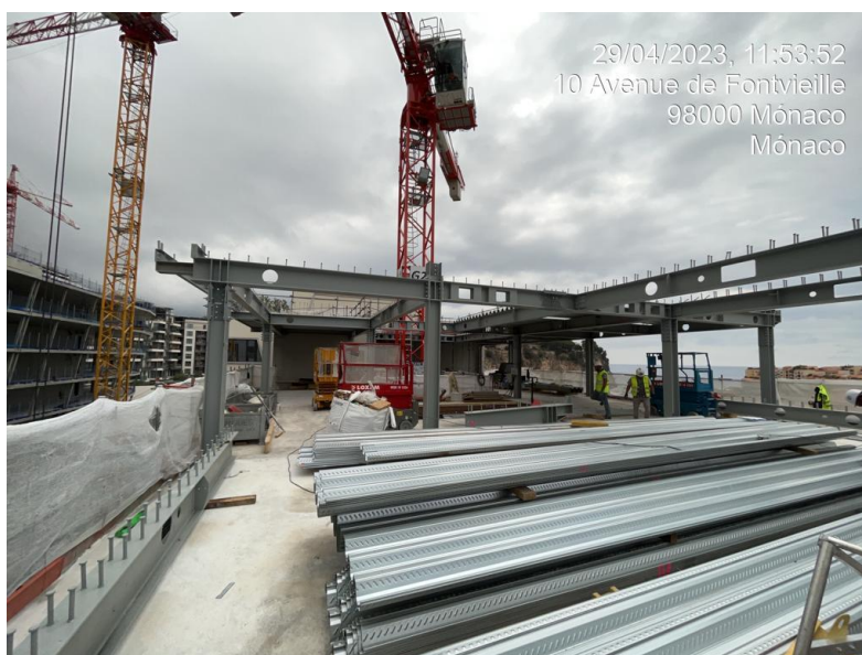
Figura 56 - Montagem do Piso 6 do Bloco A (Fonte: Obra SMEG, 2023)
