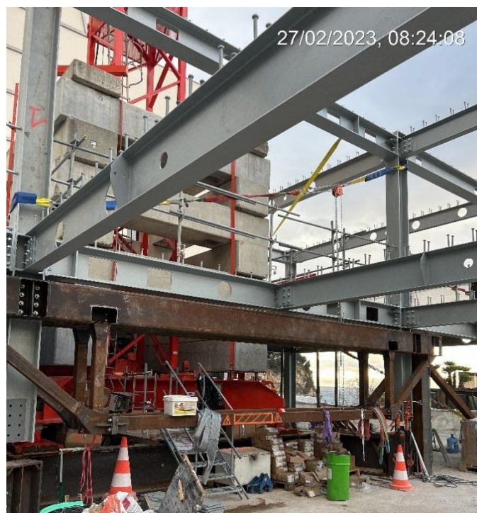
Figura 32 - Estrutura Provisória em Obra (Fonte: Obra SMEG, 2023)
