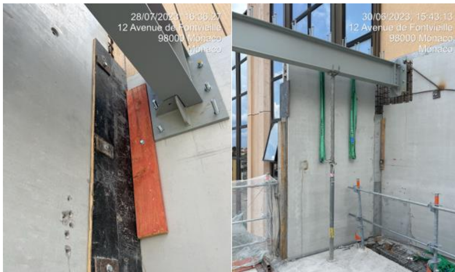
Figura 17 - Ligação Aço – Betão (Fonte: Obra SMEG, 2023)
