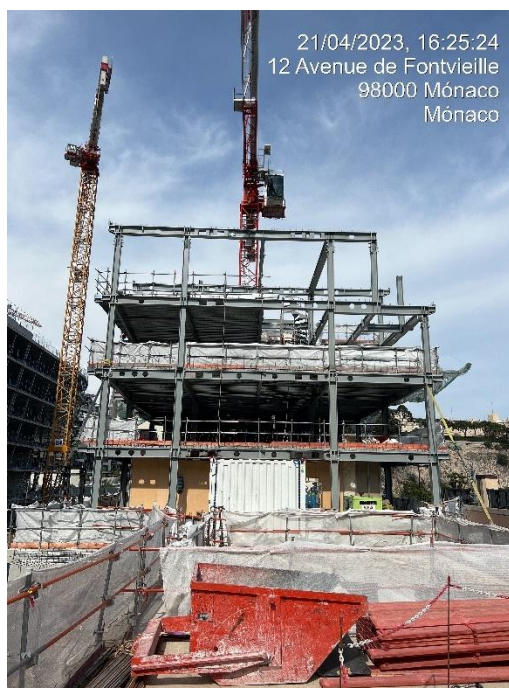
Figura 55 - Montagem do Piso 8 e 9 (Fonte: Obra SMEG, 2023)
