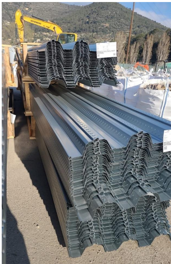
Figura 10 - Receção em Obra de Carga de Chapa Colaborante (Fonte: Obra SMEG, 2023)
