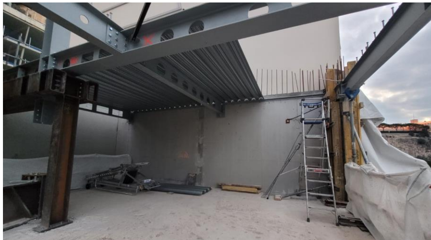
Figura 12 - Instalação da Chapa Colaborante (Fonte: Obra SMEG, 2023)
