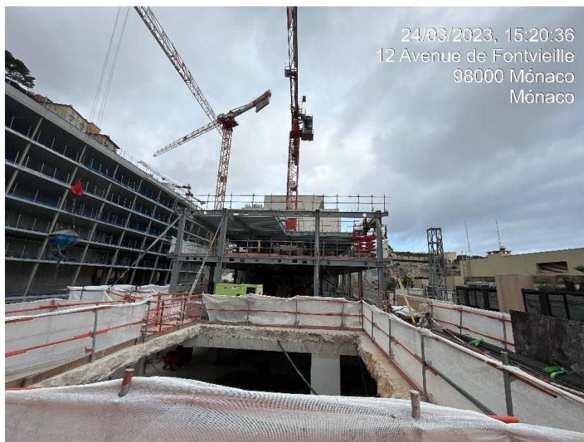
Figura 54 - Montagem do Piso 7 do Bloco C (Fonte: Obra SMEG, 2023)
