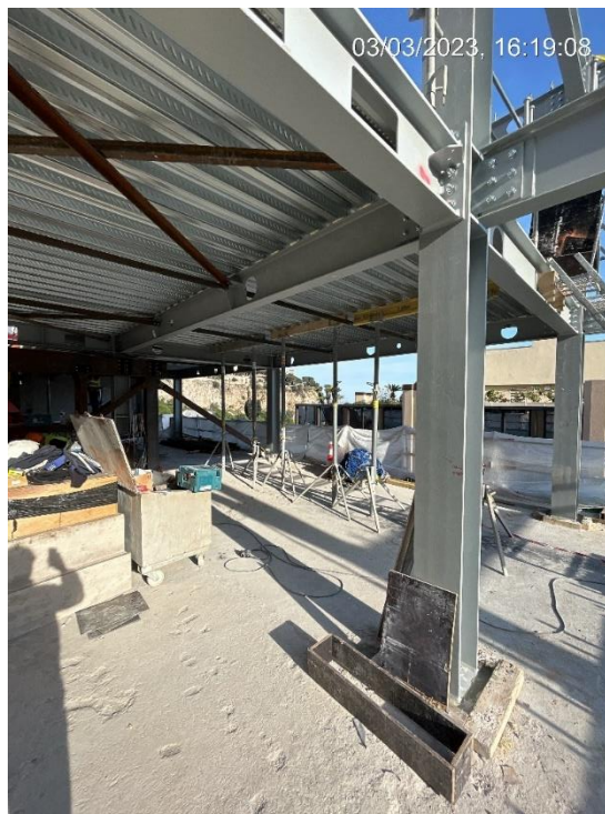
Figura 44 - Cantoneira Instalada em Obra (Fonte: Obra SMEG , 2023)
