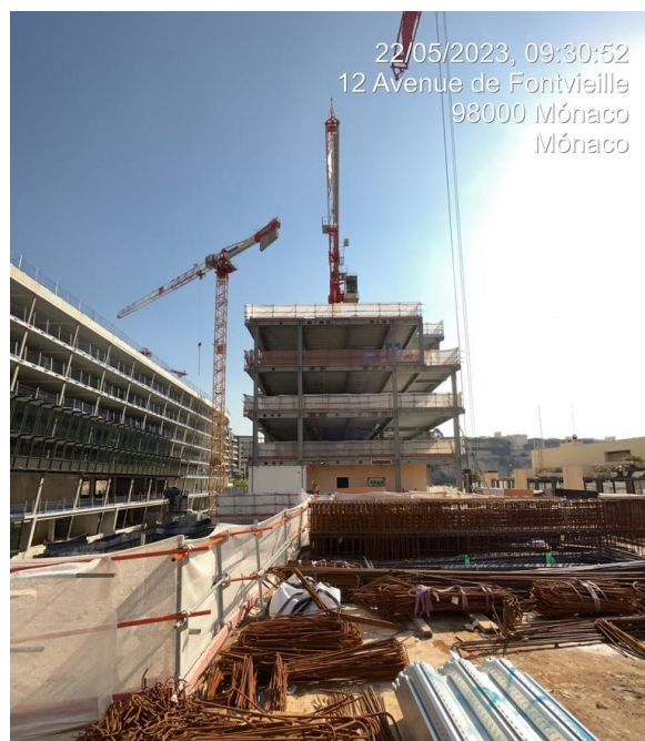
Figura 57 - Montagem do Piso 9 do Bloco C (Fonte: Obra SMEG, 2023)
