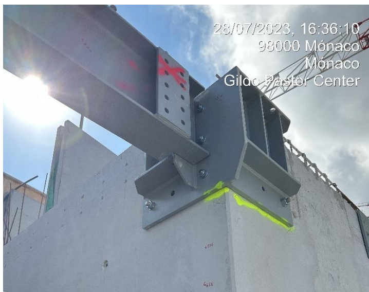
Figura 34 - Chumbadouro Instalado ao Betão (Fonte: Obra SMEG, 2023)
