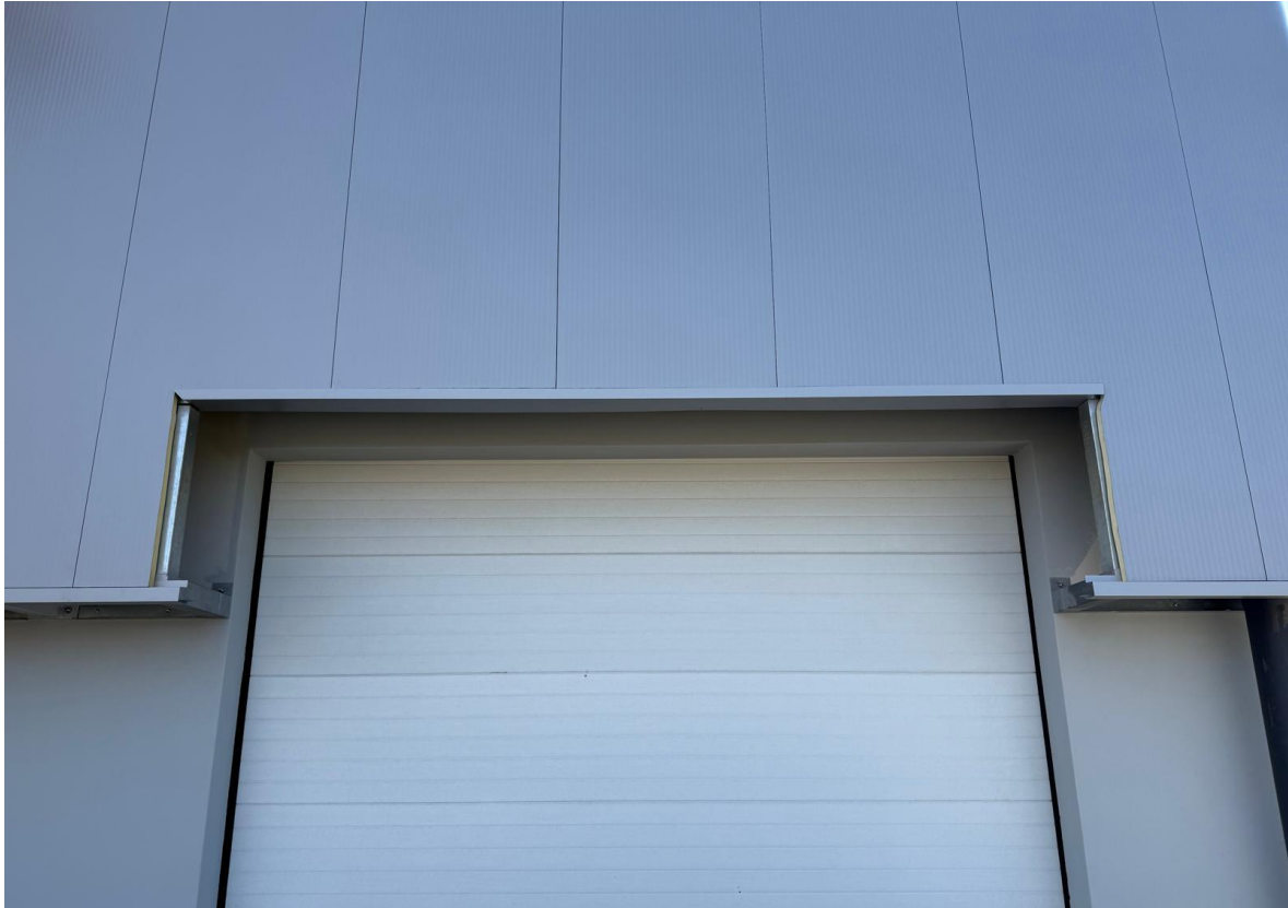
Figura 7.33 – Projeção da entrada veicular na fachada (Coberfer, 2025)
