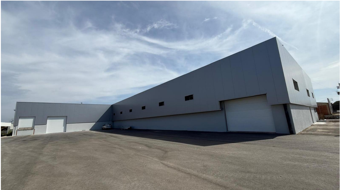
Figura 7.35 – Obra concluída (Coberfer, 2025)
