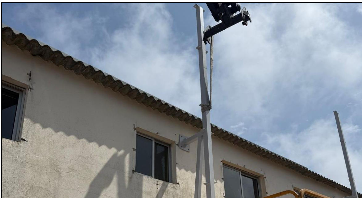
Figura 7.30 – Montagem da estrutura primária de aço (Coberfer, 2025)
