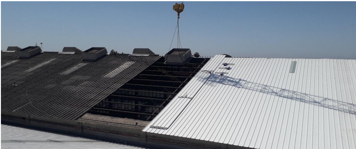
Figura 3.2 – Intervenção realizada na obra OB.129-24 (Coberfer)
