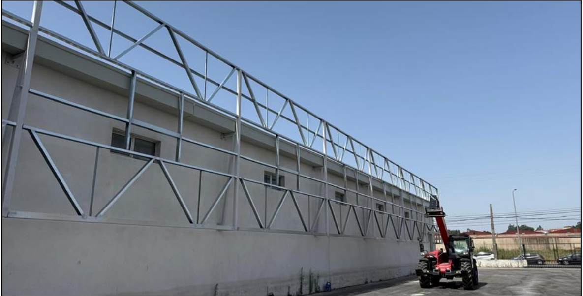
Figura 7.31 – Montagem da estrutura galvanizada (Coberfer, 2025)
