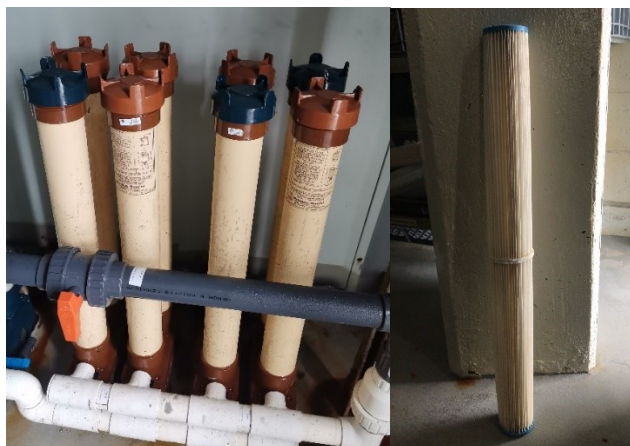
Figura 9- Filtros de cartucho, na figura da esquerda estão representados os invólucros, na figura da direita está representado um filtro de cartucho.
