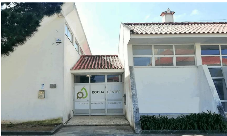
Figura 8. Instalações do RochaCenter (RochaCenter, 2020)
