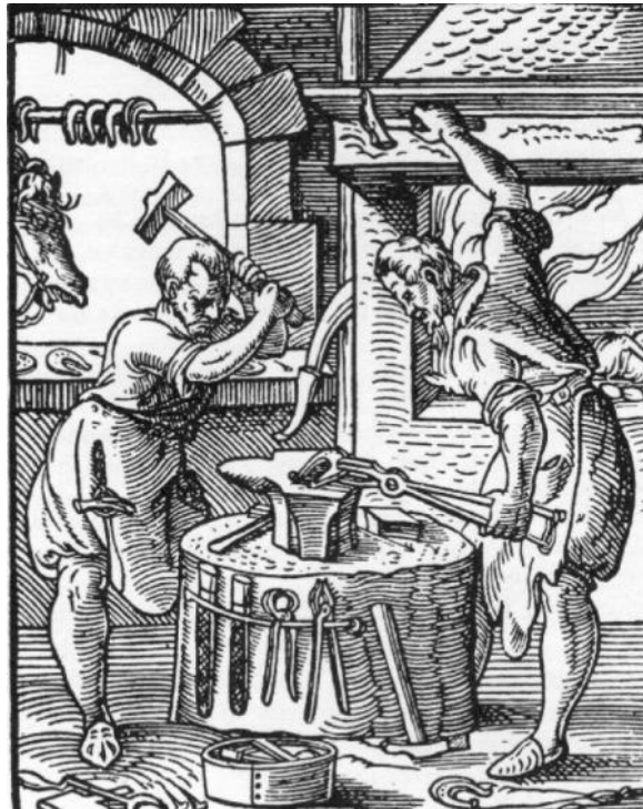
Figura 1 - Ilustração do processo de forjamento em 1500 [1]
