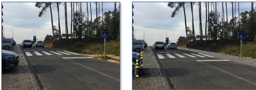
Figura 65 – Proposta de solução para execução do passeio e instalação de pilaretes flexíveis junto a travessia pedonal 108
