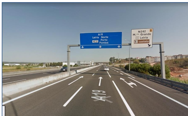
Figura 30 – Troço da Via Coletora da A19 Leiria [29]
