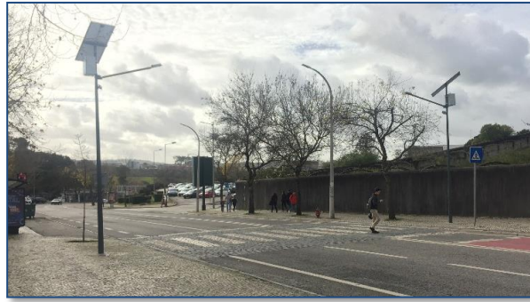
b) Luminárias verticais direcionada a travessia com recurso a sistemas de painel fotovoltaico
