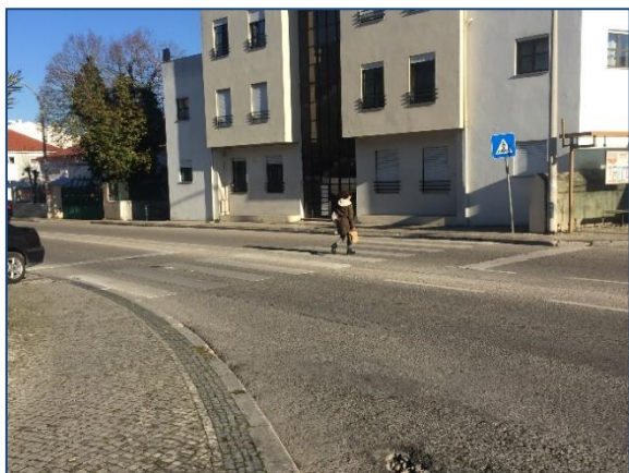
Figura 41 – Ausência de rebaixamento do lancil
