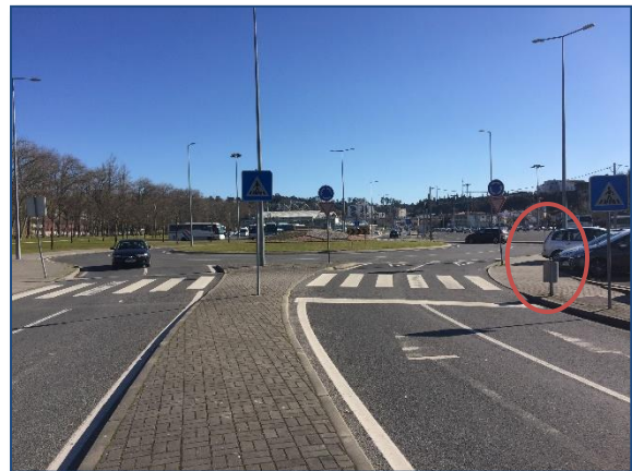
b) TP 183 – Avenida Bernardo Pimenta
