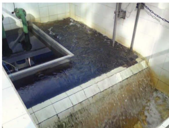
Figura 29 – Saída efluente final
