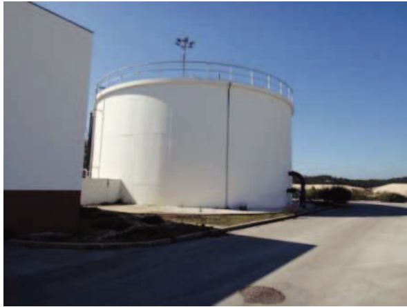
Figura 19 – Silo de lamas digeridas
