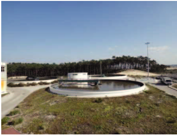
Figura 11 – Decantadores primários
