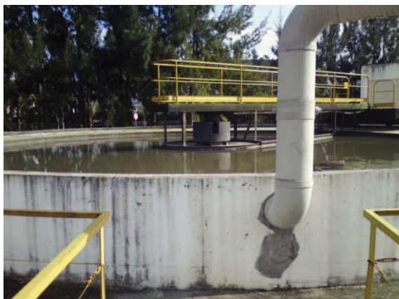
Figura 26 – Decantação primária
