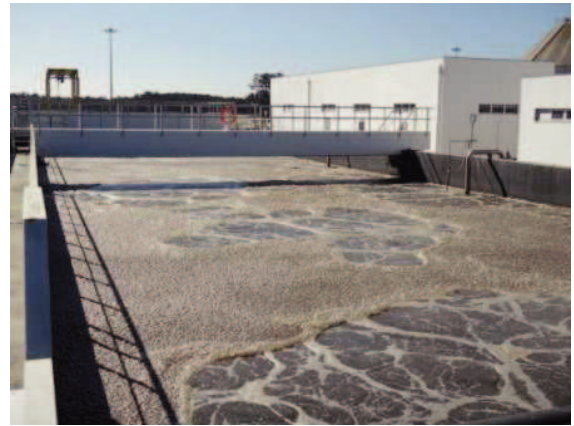
Figura 12 – Tanque de lamas ativadas
