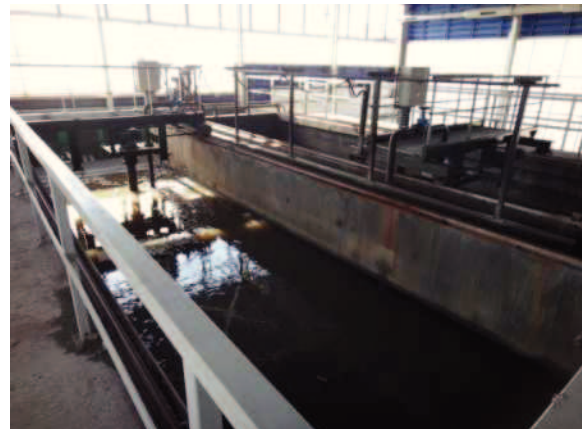
Figura 10 – Desarenador/ Desengordurador
