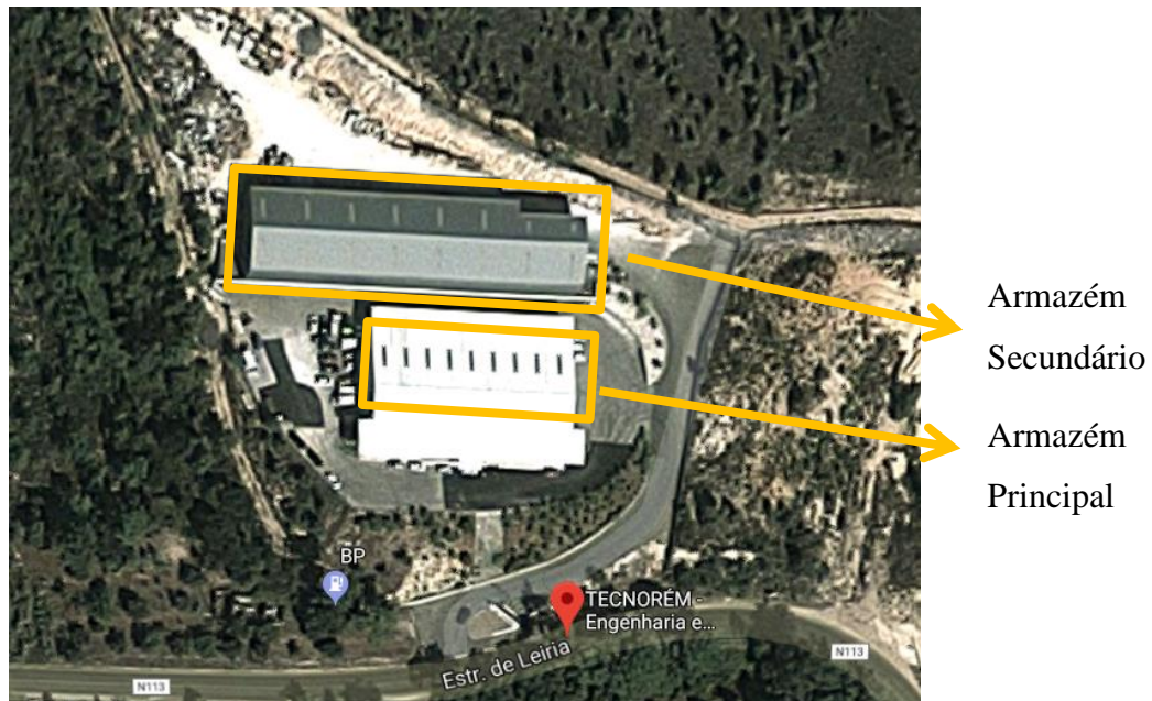
Figura 9: Armazéns da empresa
