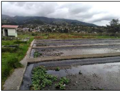
Figura 59. Estanques con macrófitas flotantes (Jacinto de agua).
