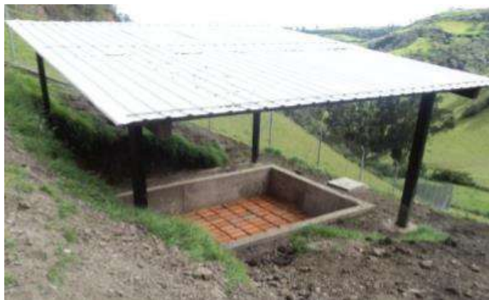
Figura 27. Lecho de secado de lodos, PTAR Ubillus, Pintag-Ecuador. Fuente: Velasco (2017).
