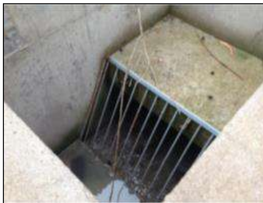
Figura 16. Rejas de cribado, PTAR Ubillus, Pintag-Ecuador. Fuente: Chiriboga (2016).
