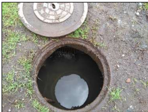
Figura 37. Unidad de control y distribución de caudales de ingreso.
