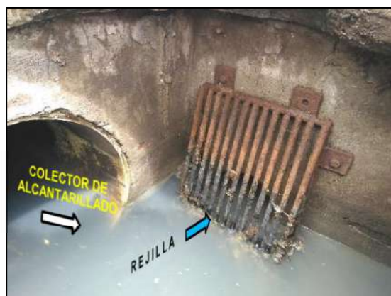
Figura 39. Reja de desbaste de la obra de toma.
