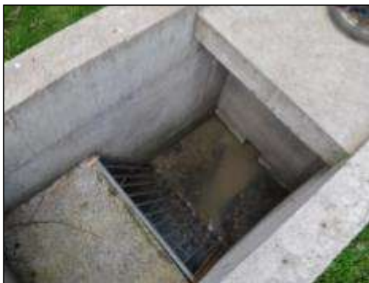
Figura 16. Rejas de cribado, PTAR Ubillus, Pintag-Ecuador. Fuente: Chiriboga (2016).
