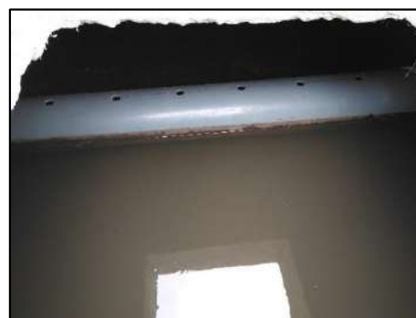
Figura 53. Filtro anaerobio de flujo ascendente, FAFA.
