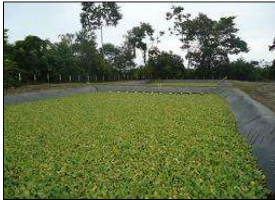
Figura 24. Humedales artificiales, PTAR Flor y Selva, Molleturo-Ecuador.
