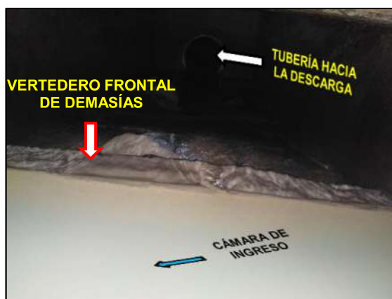
Figura 38. Separador de caudales de ingreso.
