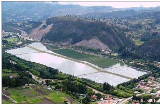
Figura 25. Lagunas de estabilización, PTAR Ucubamba, Ucubamba-Ecuador.
