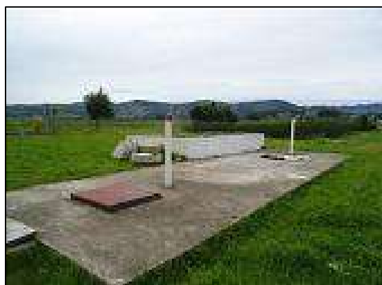
Figura 21. Tanque séptico, PTAR Churuguzo, Victoria del Portete-Ecuador. Fuente: https://bit.ly/2oEKA8 (accedido el 04 de abril de 2018).
