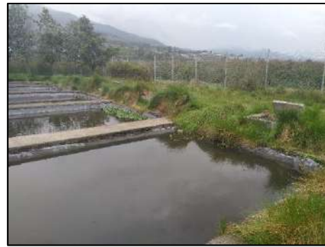
Figura 59. Estanques con macrófitas flotantes (Jacinto de agua).
