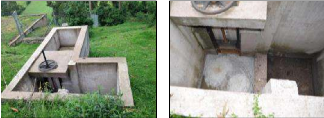
Figura 19. Rejas de cribado, PTAR Ubillus, Pintag-Ecuador.
