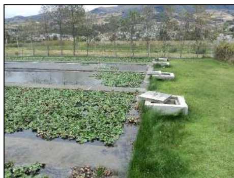
Figura 82. Desborde de caudal en estanques con macrófitas flotantes (imagen izquierda), distribuidor de caudal y sedimentador (imagen derecha), PTAR “Huaycopungo Sur”.
