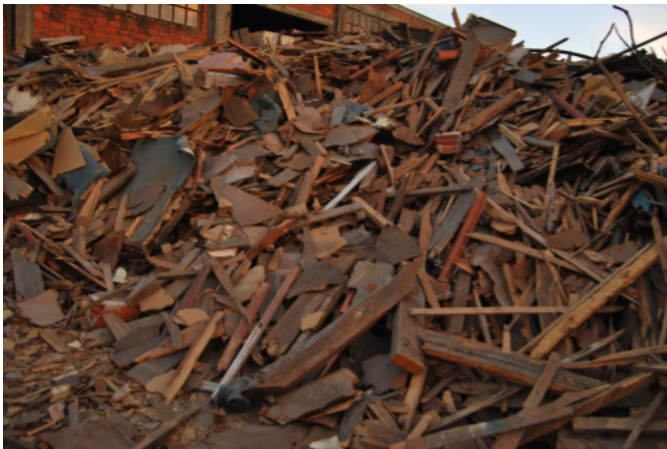
Fig.12. Pilha de madeira durante o processo de 'demolição'. 05-09-2017
