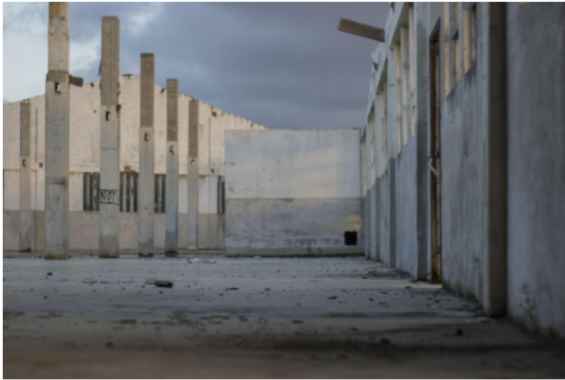
Fig.11. Piso do ateliê depois de ser 'demolido'. 16-06-2018
