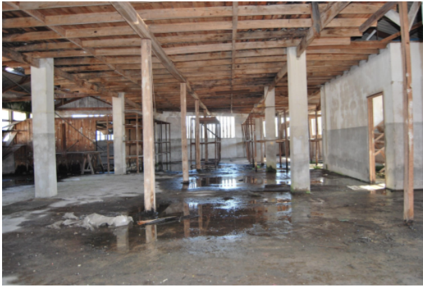
Fig.10. Piso do ateliê antes de ser 'demolido'. 01-03-2016
