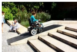
Figura 6 - Rampa de acesso na via pública, em Lisboa [25].
