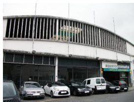
Figura 103 - Traseiras do terminal rodoviário.
