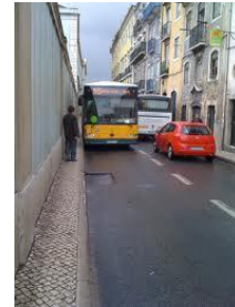
Figura 2 - Insuficiente largura do passeio numa rua em Lisboa [21].
