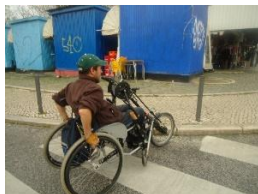
Figura 3 - Lancil com desnível acentuado numa rua em Lisboa [22].
