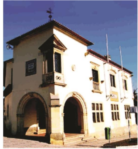
Figura 33 – Edifício do Turismo (Fonte cm-tomar.pt )
