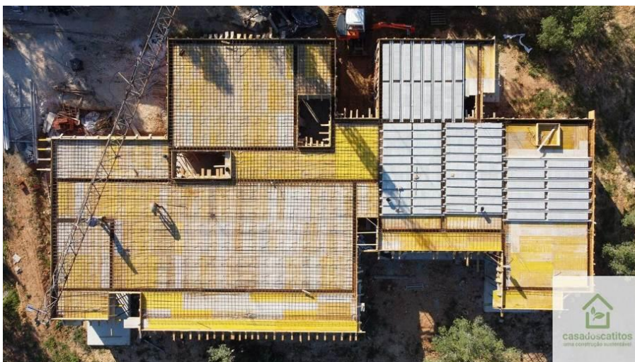
Figura 15- Trabalhos de preparação de laje maciça e aligeirada.
