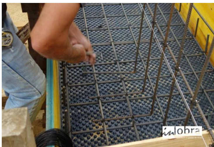
Figura 56- Impermeabilização das fundações em obra. https://forumdacasa.com/discussion/53555/1/boas-praticas-fundacoes/ . 2023
