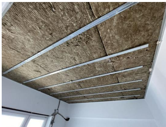
Figura 63- Isolamento térmico de laje, recorrendo a lã de rocha e teto falso. www.space lovers.pt . 2023
