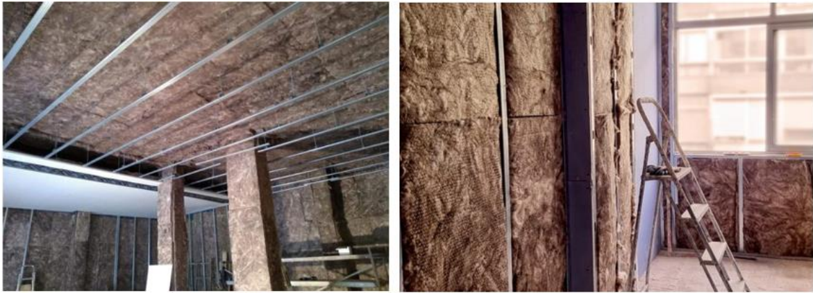
Figura 71- Isolamento acústico com lã mineral em paredes e tetos. Volcalis. 2023
