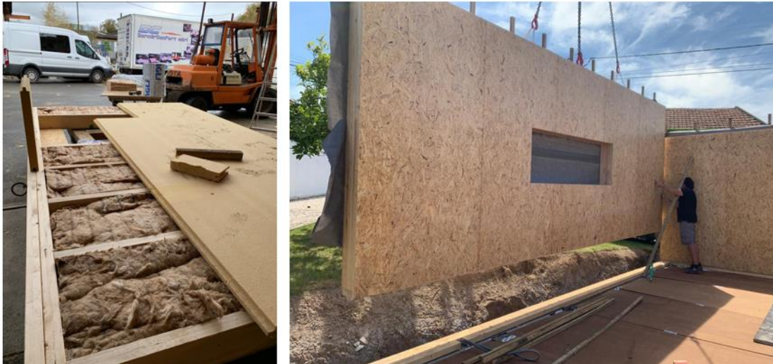
Figura 43- Parede em fábrica e no momento de aplicação. Santobois. 2023
