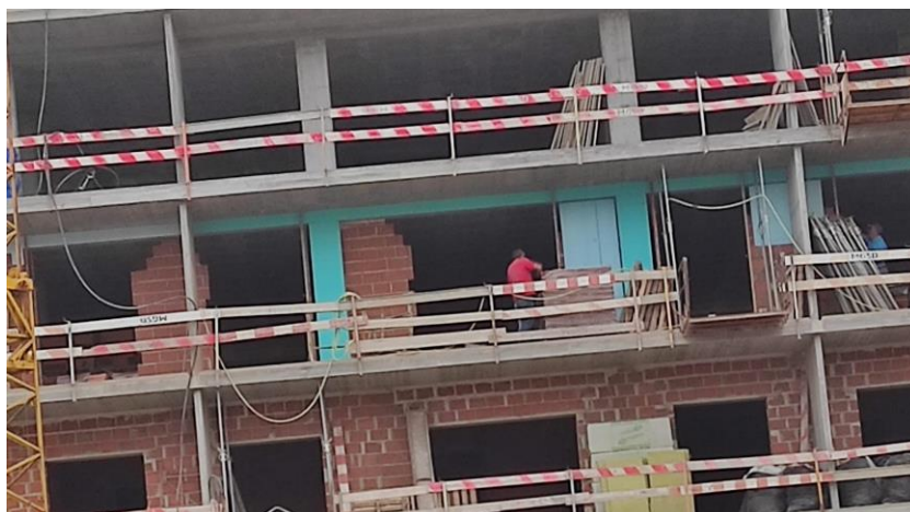
Figura 64- Aplicação de isolamento em pilares e vigas. Fotografia da autoria de Luis Parreira. 2023
