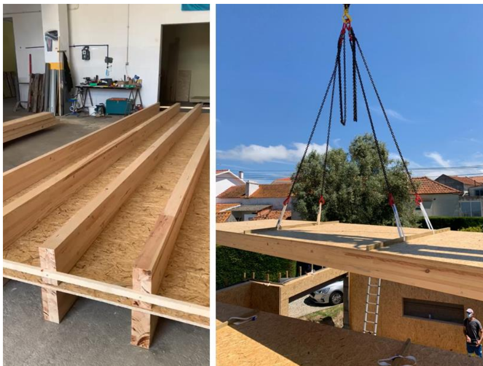
Figura 45- Laje de piso em fábrica e no momento de aplicação. Santobois. 2023
