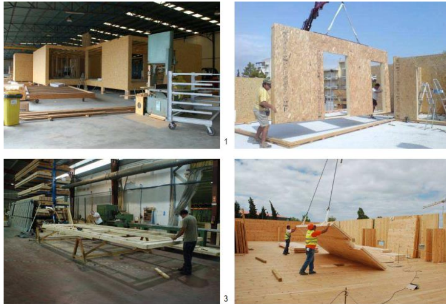
Figura 4- Construção de painéis em fábrica e assemblagem em obra. Morgado, L. 2015.
