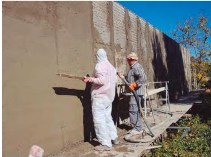
Figura 27- Exemplo de paredes em fase de projeção de microbetão. Baupanel® System. 2023
