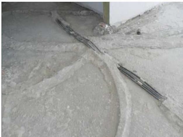
Figura 72- Passagem de tubagem no pavimento. Borges, T. ISEL. 2012
