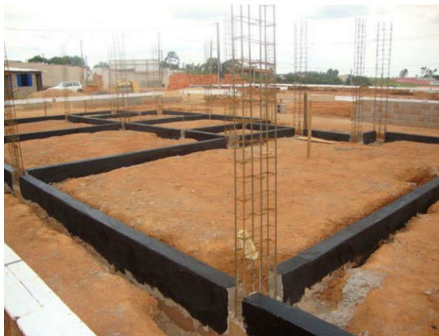
Figura 58- Impermeabilização de fundações em obra com tela emulsão asfáltica.
