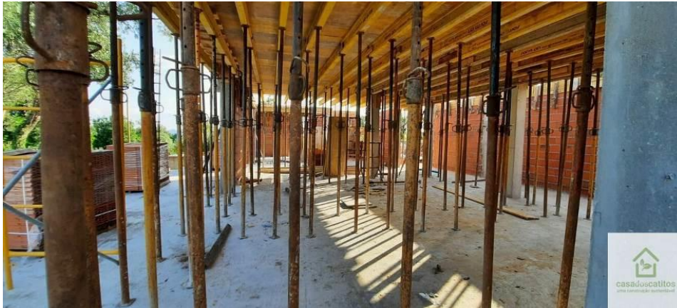
Figura 16- Trabalhos de preparação de laje maciça e aligeirada – perspetiva inferior ( https://casadoscatitos.com/pt/blog/2020/07/10/segunda-laje/ ). (2020)
