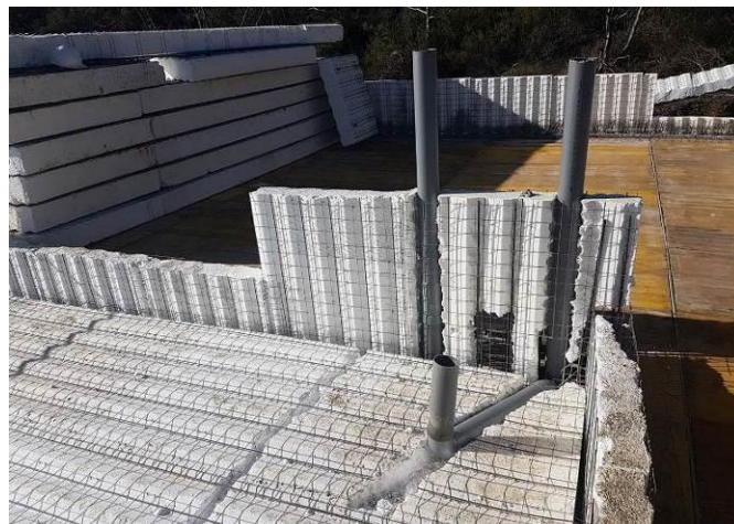
Figura 28- Exemplo de preparação de laje para betonagem. Baupanel® System. 2023
