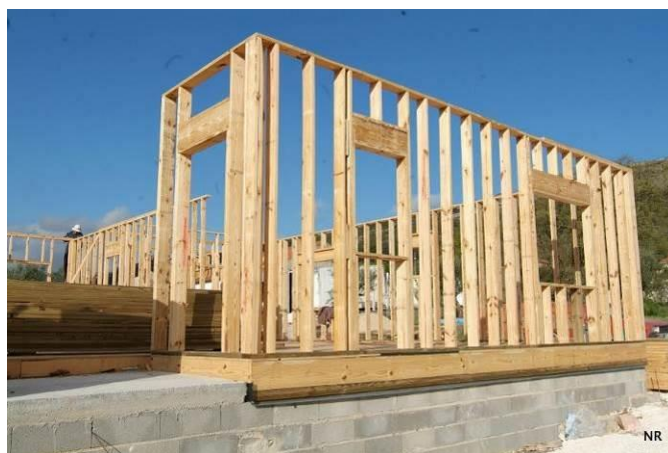
Figura 3- Exemplo de miolo de estrutura Woodframe. www.casema.pt . 2023
