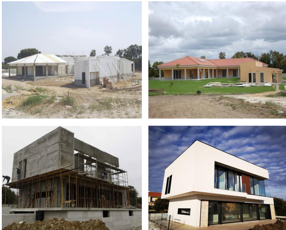
Figura 49- Exemplos de moradias com cobertura inclinada e plana. Buildity e Baupanel® System. 2023
