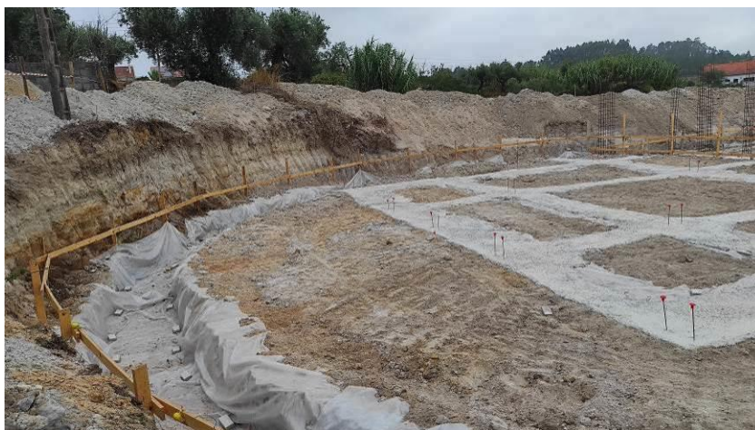
Figura 59- Impermeabilização das fundações em obra em Leiria, com manga de PVC. Autor. 2023
