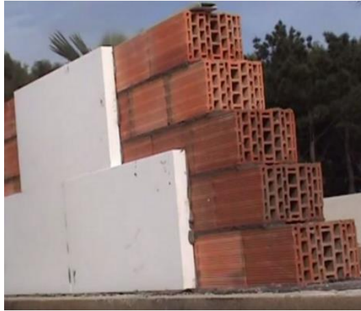
Figura 62- Parede simples de tijolo térmico com ETICS. www.cpnmestadio3.com . 2023
