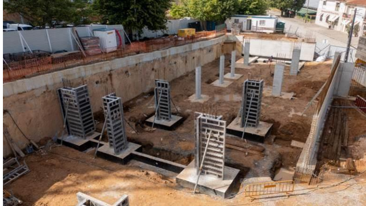
Figura 7- Fundações e pilares em obra ( https://www.riverplaza.pt/final-das-fundacoes/ ). 2023
