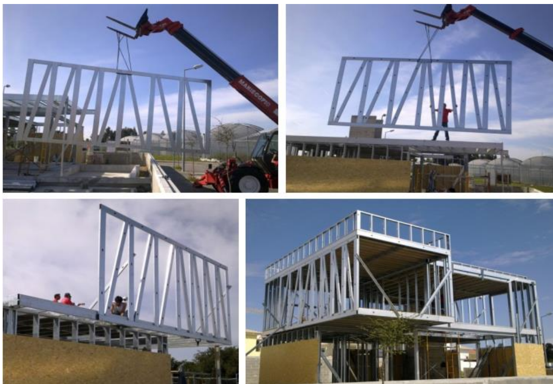
Figura 41- Montagem de estrutura LSF. Bastos, R. 2014.
