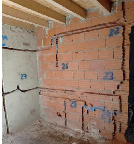
Figura 74- Abertura de roços em parede de alvenaria de tijolo. https://www.olx.pt/d/anuncio/demolio-e-abertura-de-roos-IDGsw04.html?isPreviewActive=1&sliderIndex=1 . 2023
