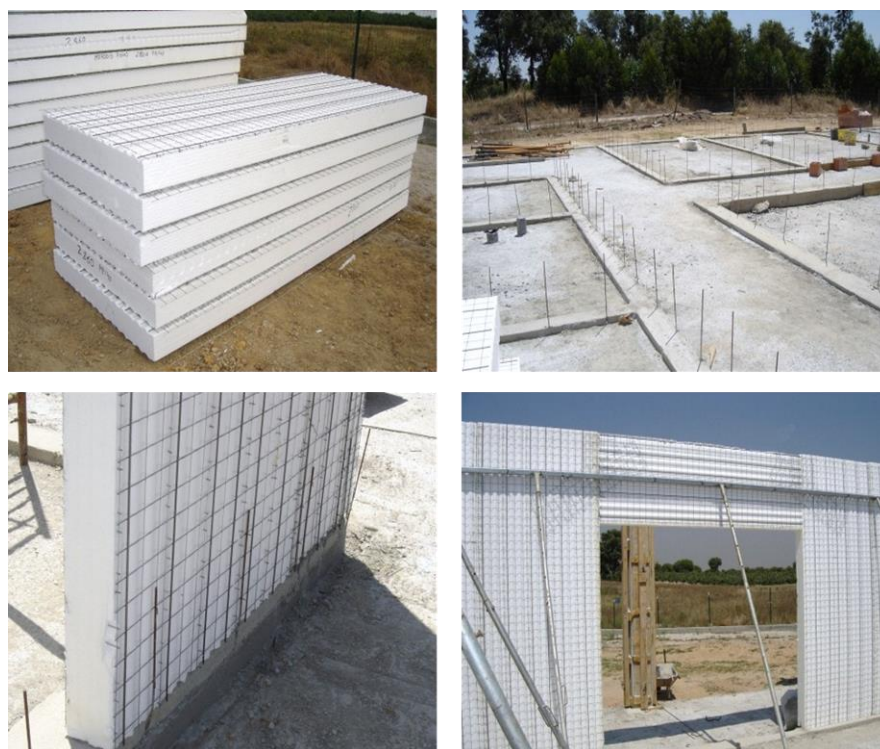
Figura 48- Sequência de aplicação dos painéis de parede. Buildity. 2023.
