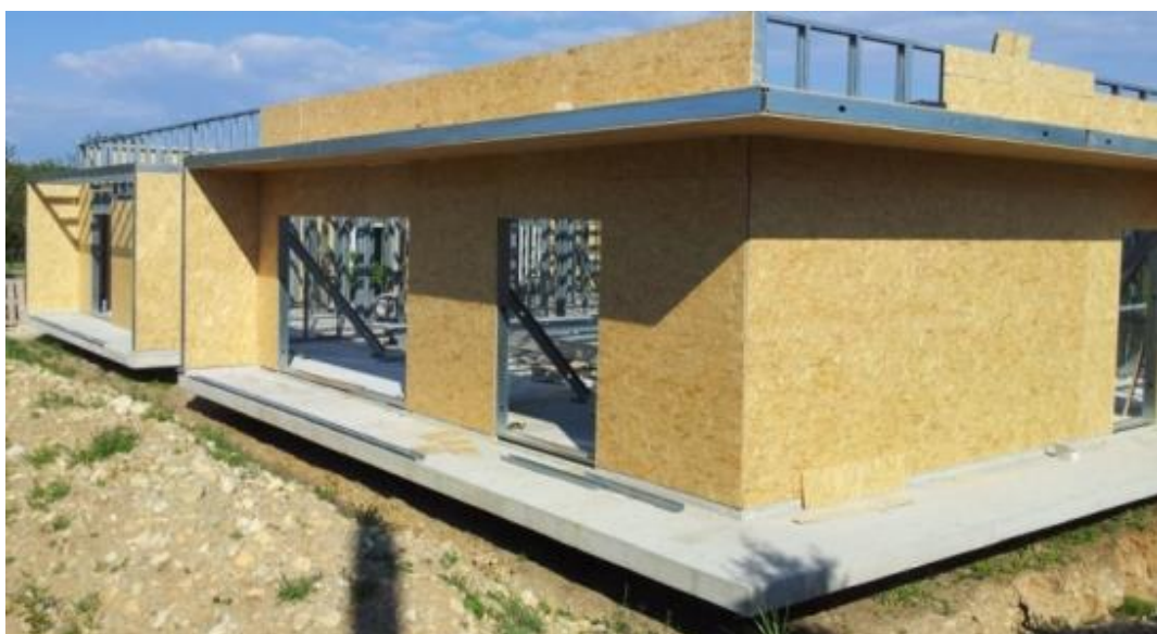
Figura 21- Revestimento exterior de estrutura LSF com placas OSB. Bastos., R. 2014
