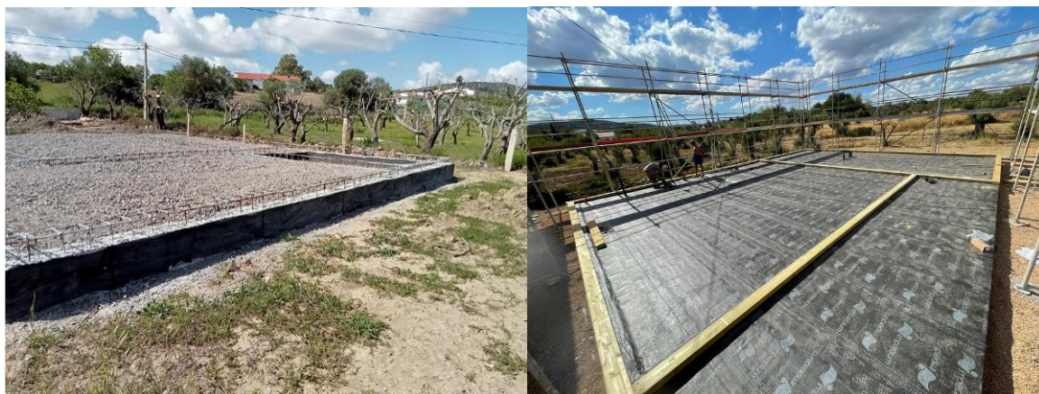
Figura 25- Pormenores de fundações de empreitadas da empresa Santoboís. Santoboís. 2023
