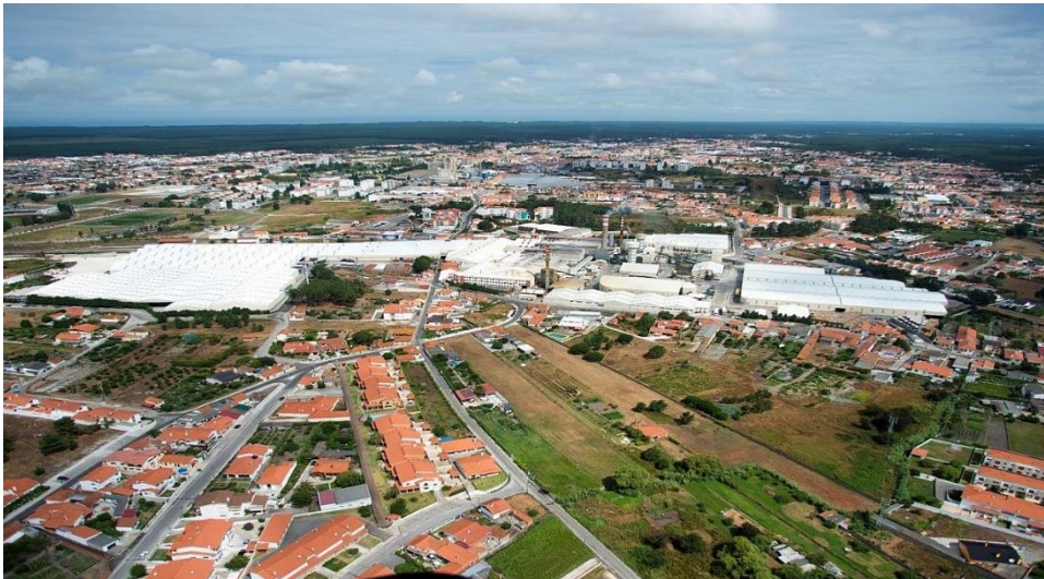
Figura 1 - Instalações da SB Vidros [1]
